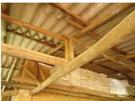
Figura 100: Detalhe da estrutura do telhado de um dos galpões. (Fonte: Foto da Autora em 24/01/2012)
