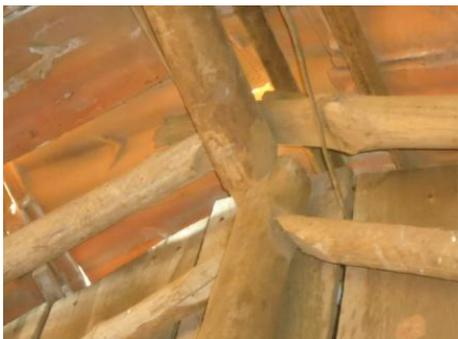
Figura 103: Detalhes Construtivos. Encaixes de madeira. (Fonte: Foto da Autora em 24/01/2012).
