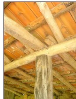
Figura 105: Detalhes Construtivos. Encaixes de madeira. (Fonte: Foto da Autora em 24/01/2012).
