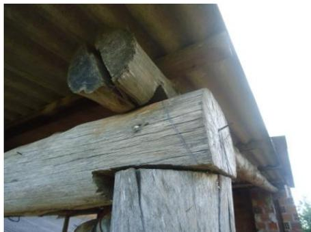
Figura 104: Detalhes Construtivos. Encaixes de madeira. (Fonte: Foto da Autora em 24/01/2012).
