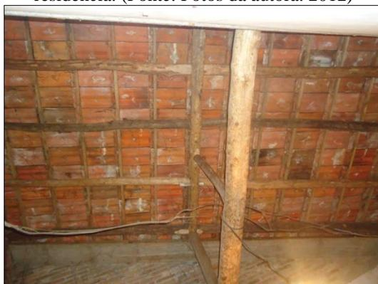
Figura 87: Detalhes da estrutura do telhado da residência. (Fonte: Fotos da autora. 2012)
