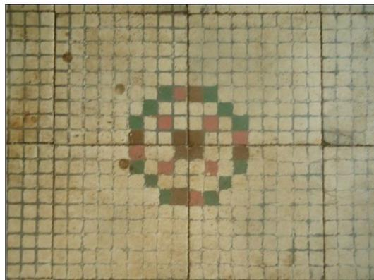
Figura 81: Detalhes de um dos pisos de ladrilhos hidráulicos. (Fonte: Fotos da autora. 2012)
