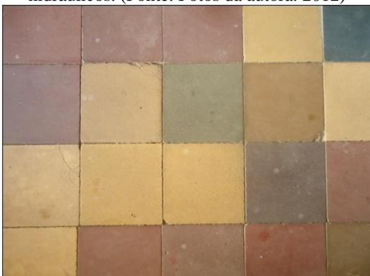
Figura 82: Detalhes de um dos pisos de ladrilhos hidráulicos. (Fonte: Fotos da autora. 2012)
