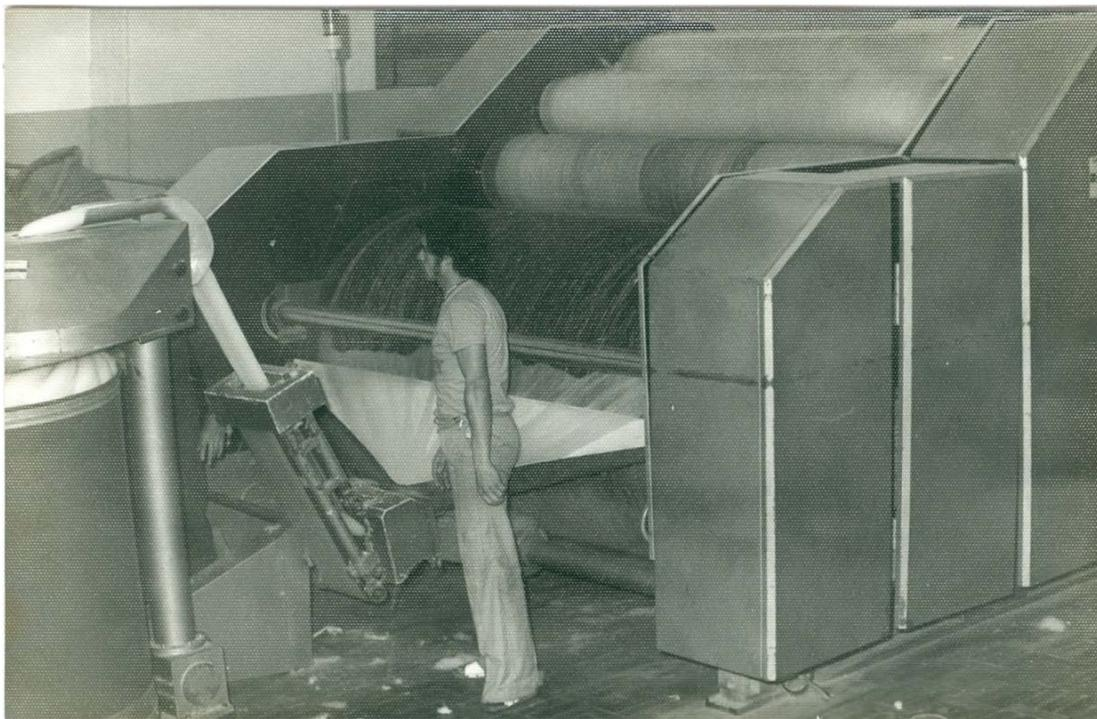
Figura 8- Máquina de cardagem de lã, fotografia PB, s/ data.
