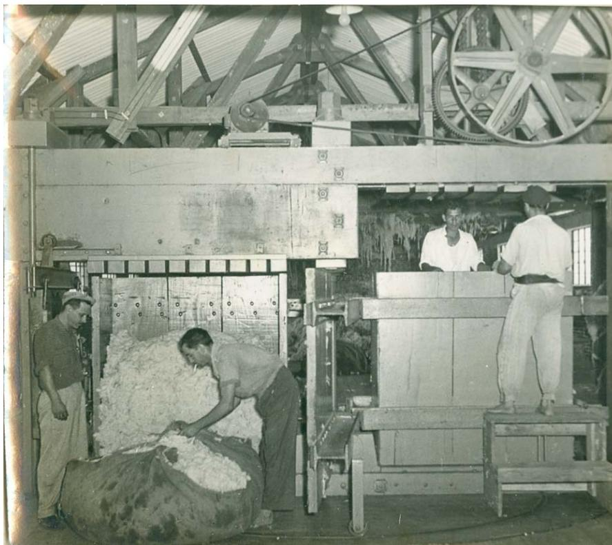
Figura 33- Máquina de prensar lã, fotografia PB, s/ data.
