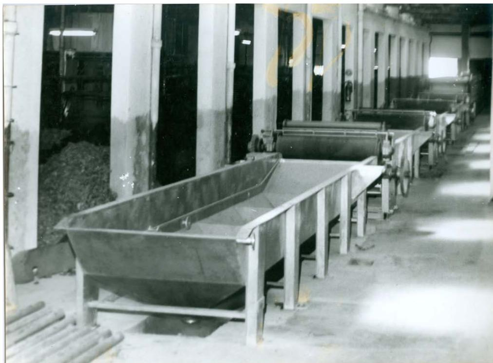
Figura 63- Máquina antiga de cardagem de lã, fotografia PB, s/ data.
