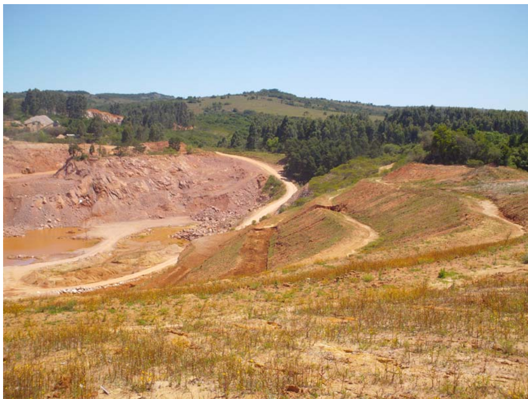
Figura 13. Detalhe da recuperação realizada na área da jazida de saibro - reconformação de talude (AD 308)
