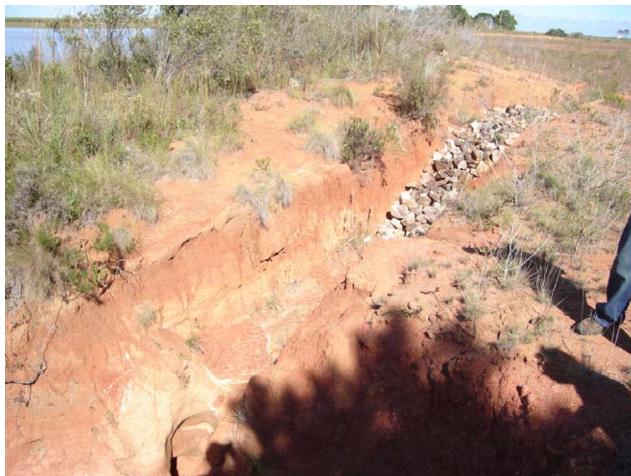
Figura 18. Obra de mitigação de carreamento de sedimentos para o interior do reservatório (AD 302).
