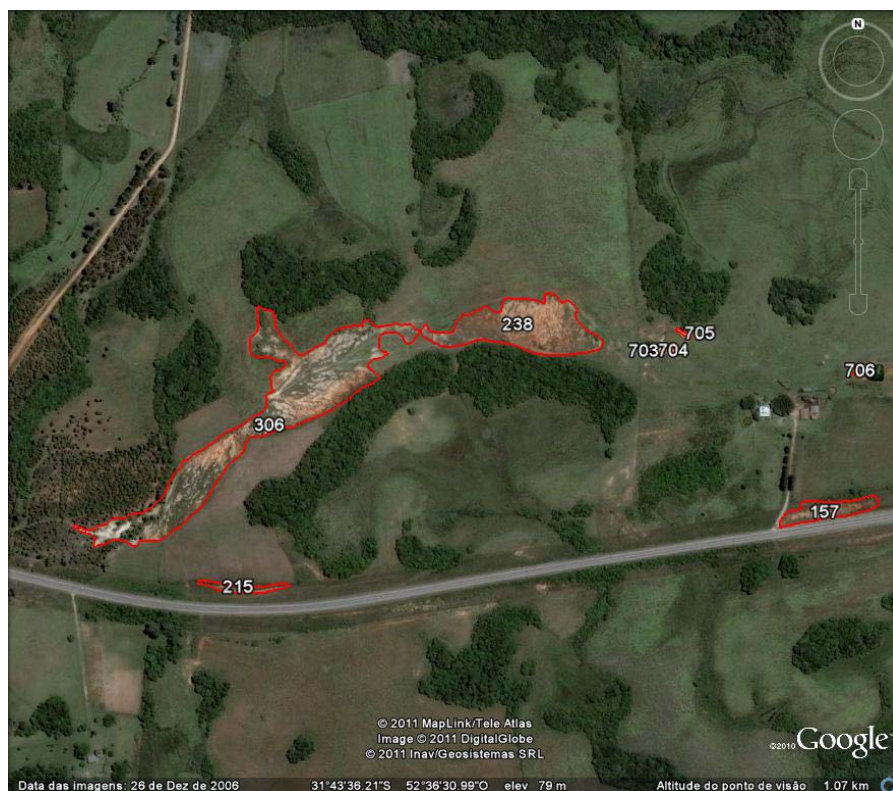
Figura 27. Imagem mostrando voçoroca junto a estrada BR392.
