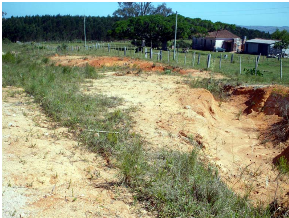
Figura 16. Área de empréstimo em estrada municipal (divisa com Morro Redondo), nas terras altas do município (AD 272).
