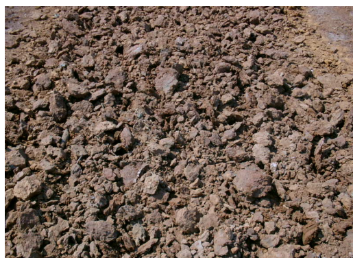
Figura 11: Estrutura laminar coesa gerada pelo tráfego intenso de máquinas pesadas (a) e quebra desta massa coesa com a escarificação (b).
