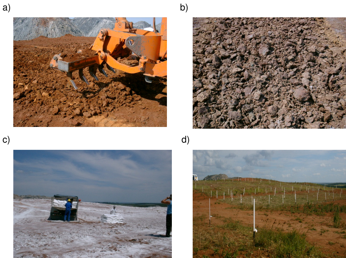
Figura 6: Processos que envolveram a instalação do experimento: (a) solo construído escarificado; (b) rompimento da camada compactada do solo construído após escarificação; (c) correção do solo construído com calcário; (d) área experimental implantada.
