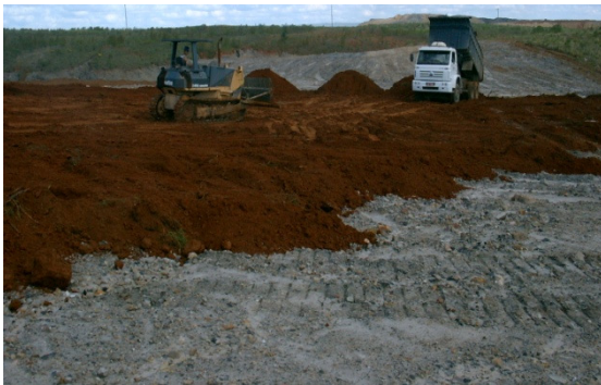
Figura 2: Processo de lavra, extração do carvão e recomposição topográfica da área minerada.
