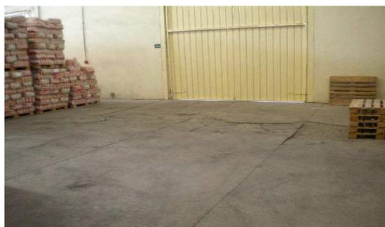
Figura 70. Piso em início de desagregação
