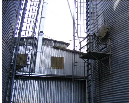
Figura 45. Escada tipo marinheiro com proteção
