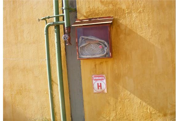
Figura 54. Rede de hidrantes e caixa com mangueira
