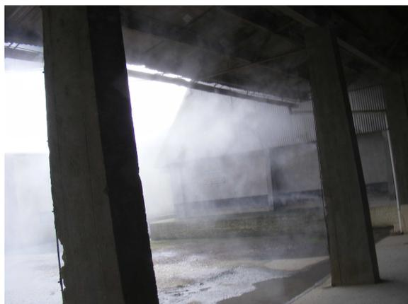
Figura 74. Cortina de água para retenção do pó
