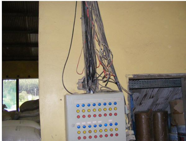
Figura 22. Fiação elétrica inadequada
