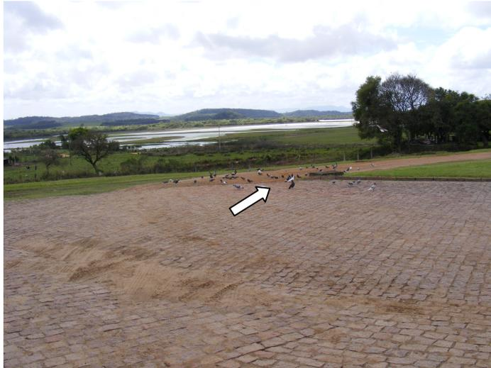
Figura 28. Piso de paralelepípedo de granito
