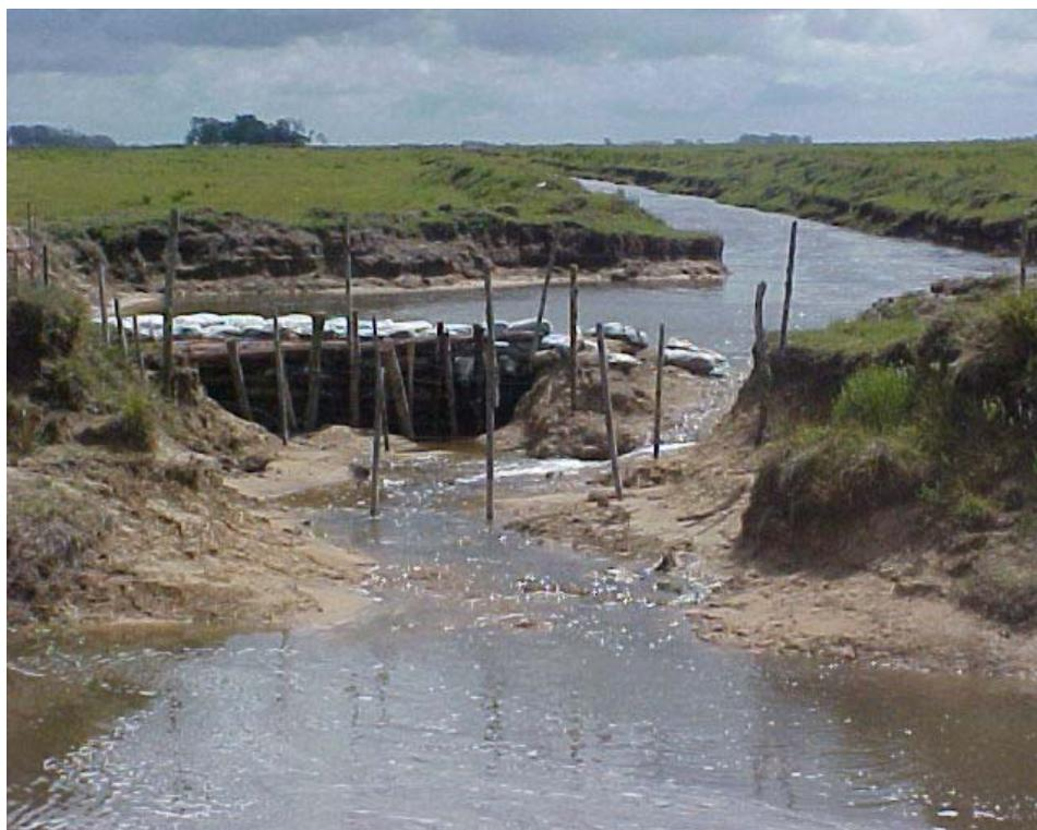
**Figura 5:** Arroio Chuí: Barramento (ataca mar) realizado por orizicultor a montante.
