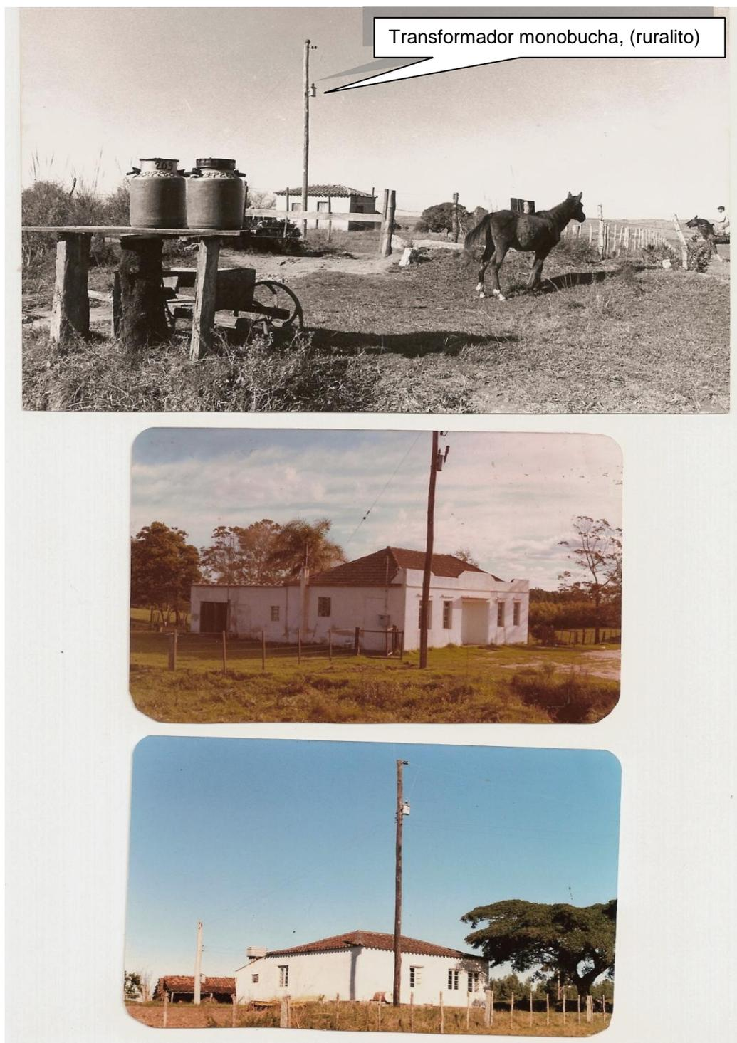
Figura 43 — Propriedades rurais com o seu transformador próprio, devido às longas Distâncias entre elas.
