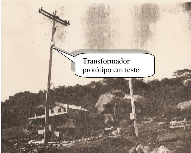
Transformador protótipo em teste
