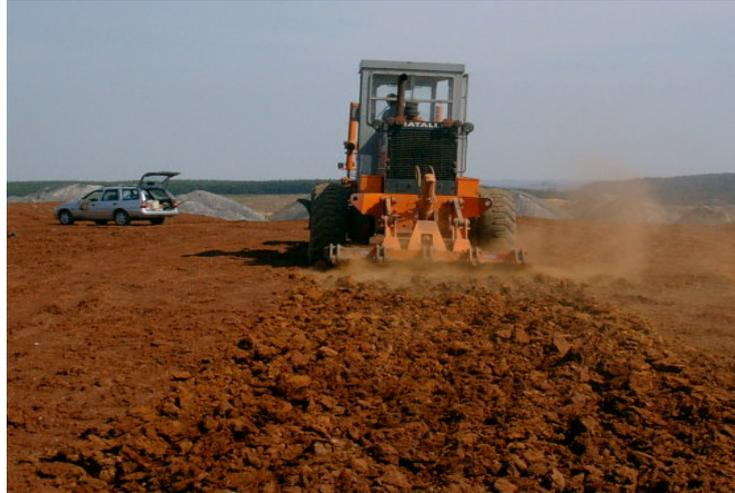
**FIGURA 7:** Patrola executando a escarificação da área experimental de Candiota, RS
