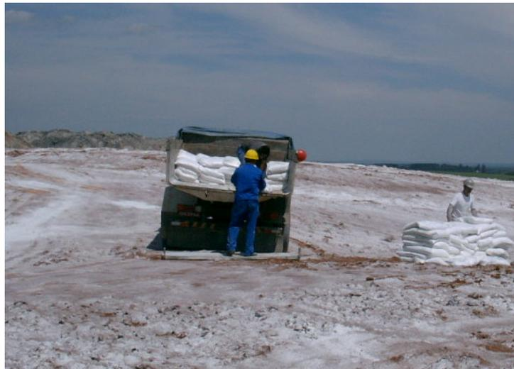
**FIGURA 8:** Aplicação de calcário na área experimental de Candiota, RS
