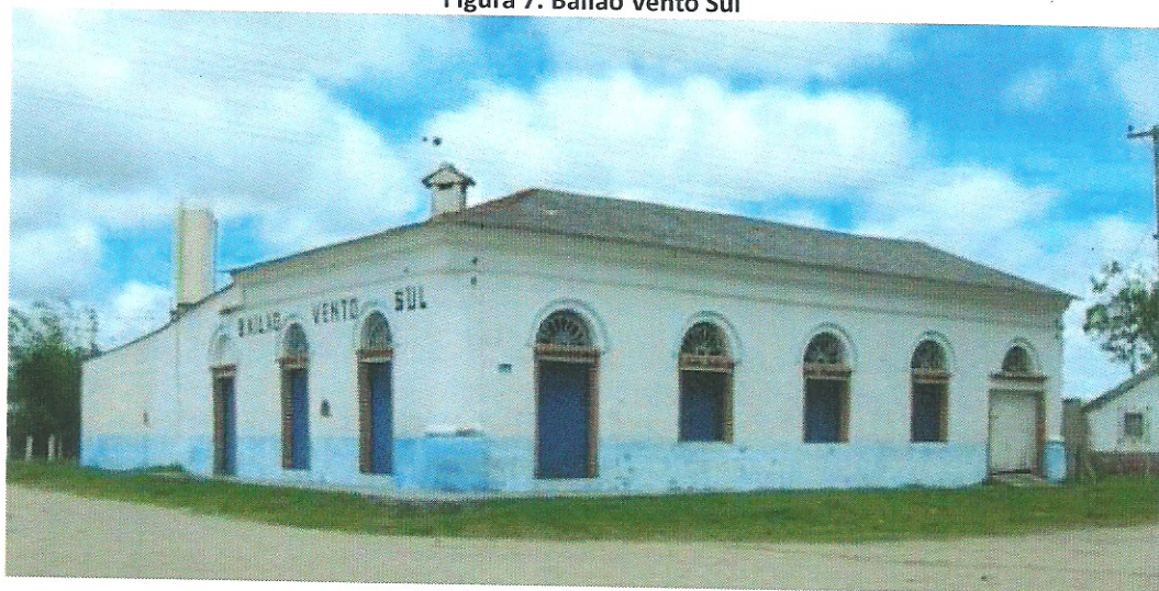
Figura 7: Bailão Vento Sul
