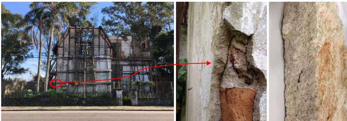
Figura 7- Creche da fábrica Rheingantz, prédio localizado na Avenida Rheingantz. Imóvel Tombado pelo IPHAE. Processo nº2778-1100/95-1. Imagens do local e da posição de extração da amostra do revestimento.
