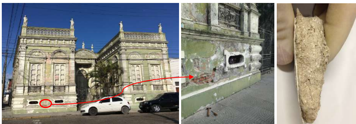
Figura 5- Centro Municipal de Cultura (1914), prédio localizado na Rua Marechal Floriano Peixoto, 91. Imagens do local e da posição de extração da amostra do revestimento.
