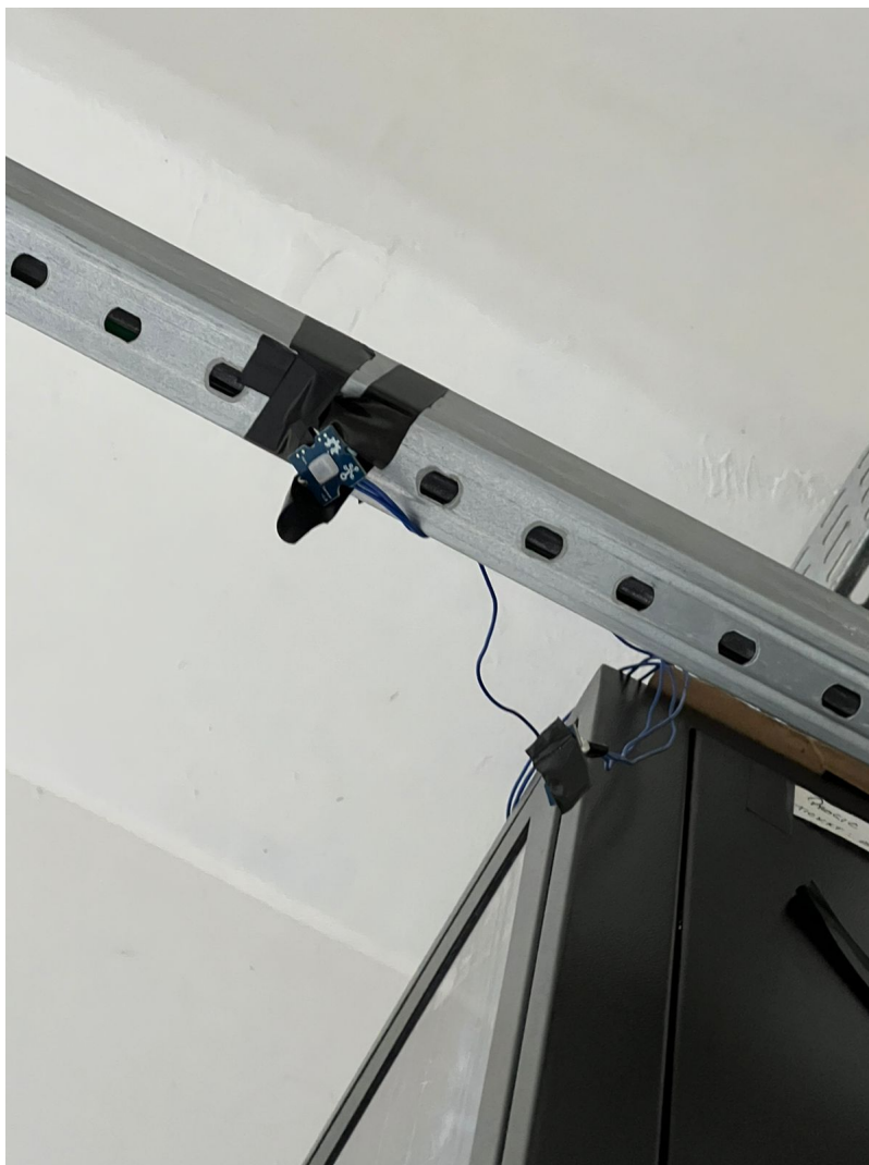
Figura 38 – Instalação do nó sensor - Sensor de Movimento
