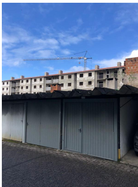
Figura 22 – Garagens no Residencial Ana Terra. Fonte: Arquivo da autora (2022).
