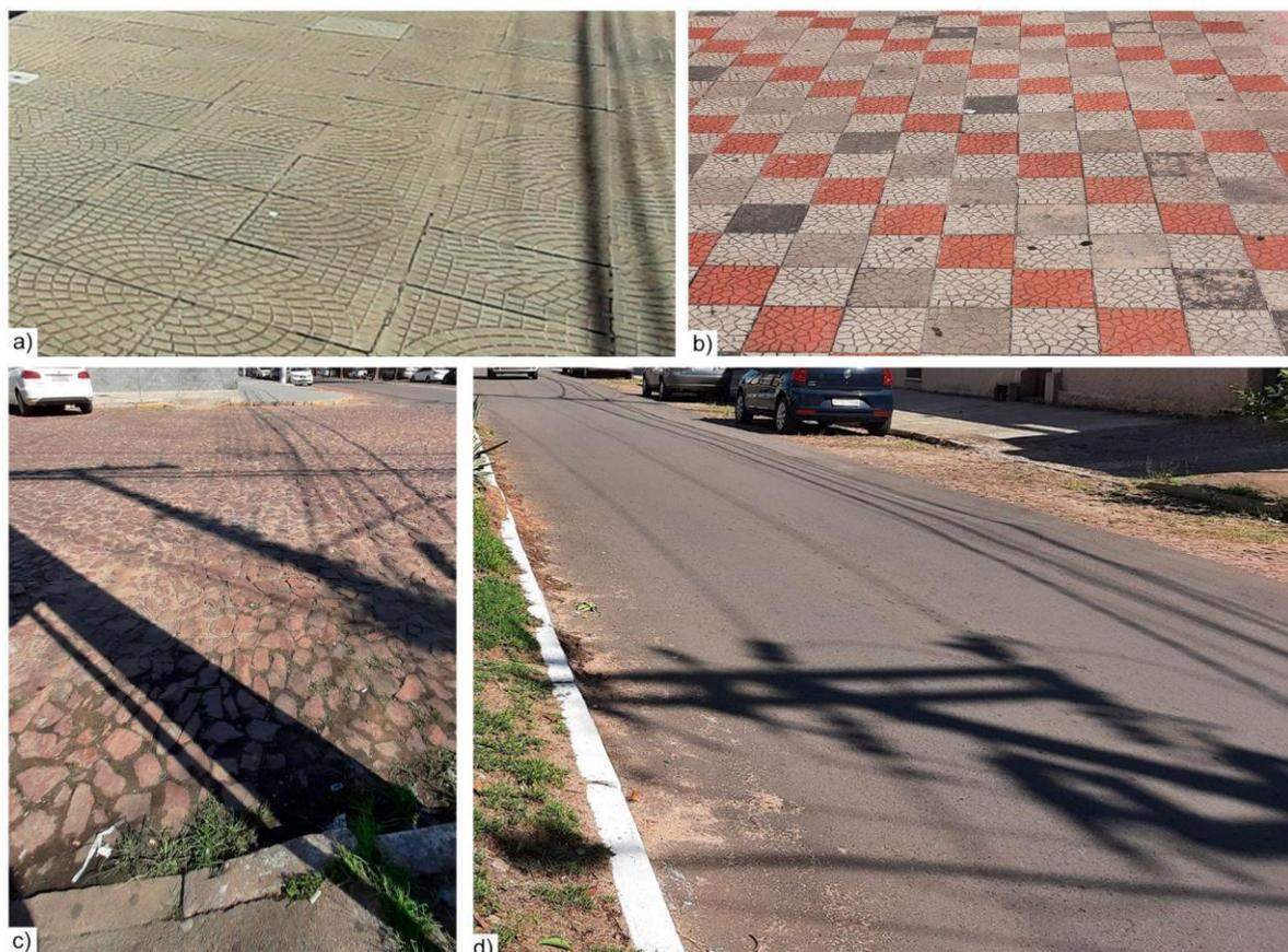
Figura 3.11: Fotos das calçadas de pisos cimentício em (a) e (b) e das vias carroçáveis com calçamento de pedra em (c) e coberta por asfalto acima do calçamento em (d).
