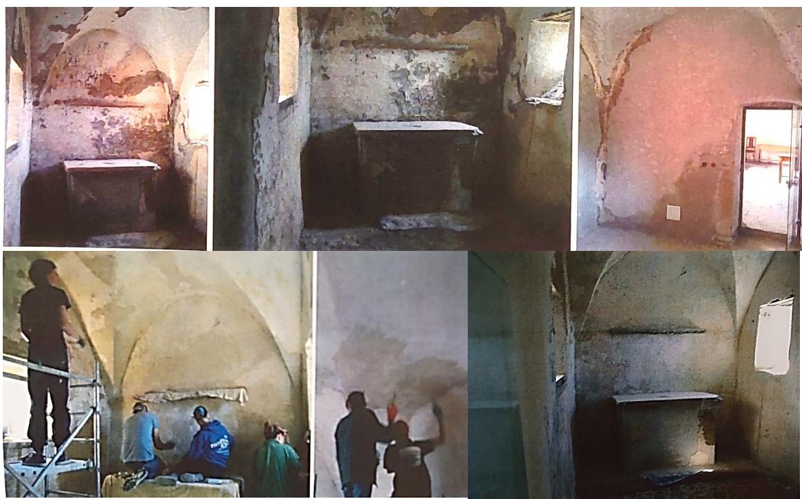
Figura 136 – Capela durante a intervenção.
