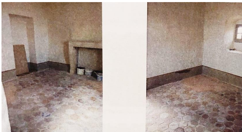
Figura 143 – Fim do canteiro de voluntários após a intervenção em 2019. Fonte : Relatório de 2018 do canteiros de voluntários fornecido pelo REMPART.
