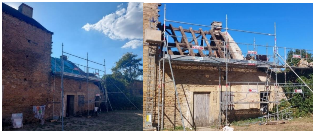
Figura 151 - Intervenção de restauração no telhado do Castelo Pontus de Tyard. Fonte: Elaborado pela autora, 2022.
