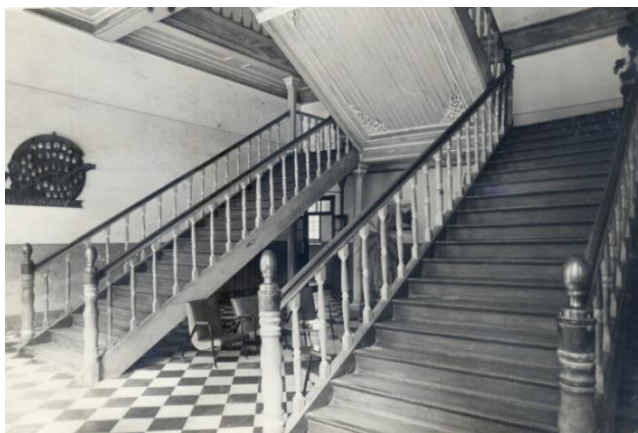
Figura 40 – Fotografia da Escadaria da Antiga Escola Militar de Rio Pardo, sem data. Fonte: Arquivo IPHAE 464 .
