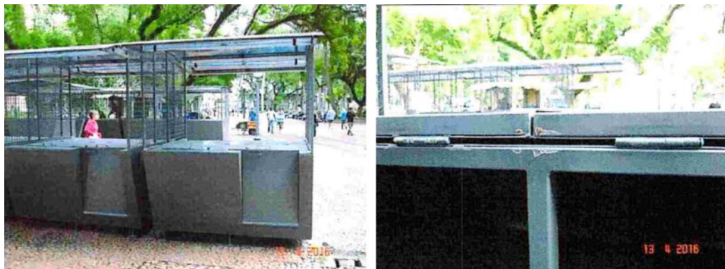
Figura 25 - Vista posterior das Bancas 01 e 02 e, danificação das pinturas, respectivamente. Fonte: PIBERNAT, 2016.
