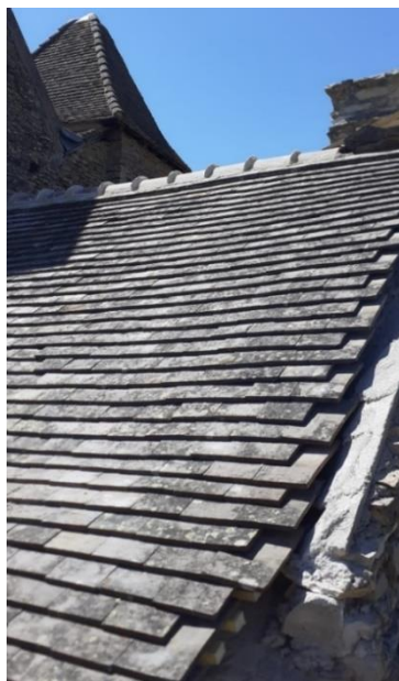
Figura 156- Detalhe da finalização da intervenção de restauração no Castelo Pontus de Tyard. Fonte: Minardi, 2022.
