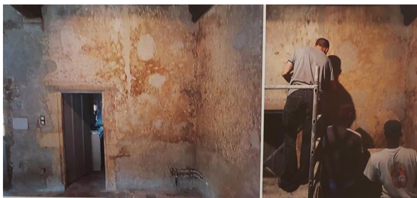
Figura 139 – Intervenção na sala da Comtesse. Fonte : Relatório de 2017 do canteiros de voluntários fornecido pelo REMPART.
