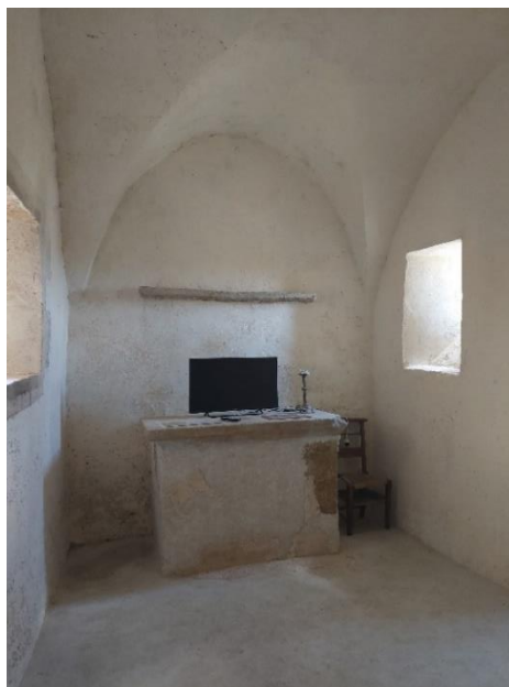
Figura 138 – Capela depois da intervenção. Fonte : Elaborado pela autora, 2022.
