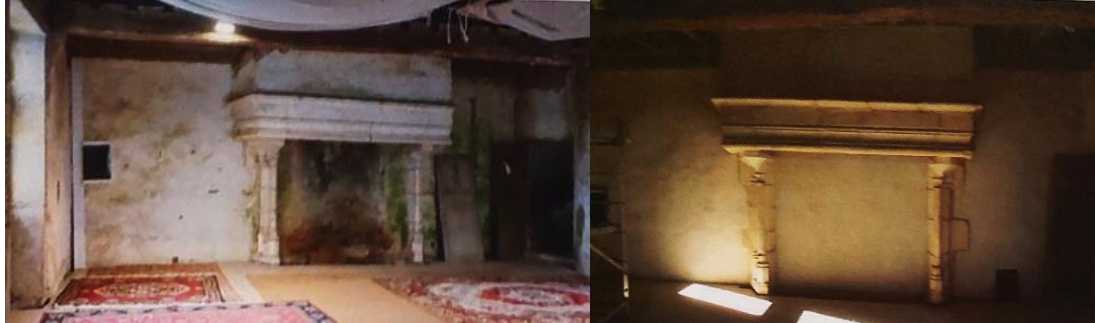
Figura 133 – Antes da intervenção no revestimento e depois da intervenção, respectivamente, no ano de 2013.
