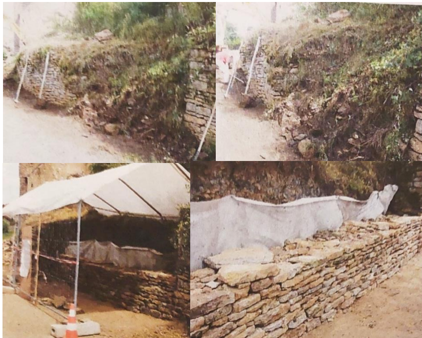
Figura 132 - Intervenção sobre o muro de Pedra-Seca.
