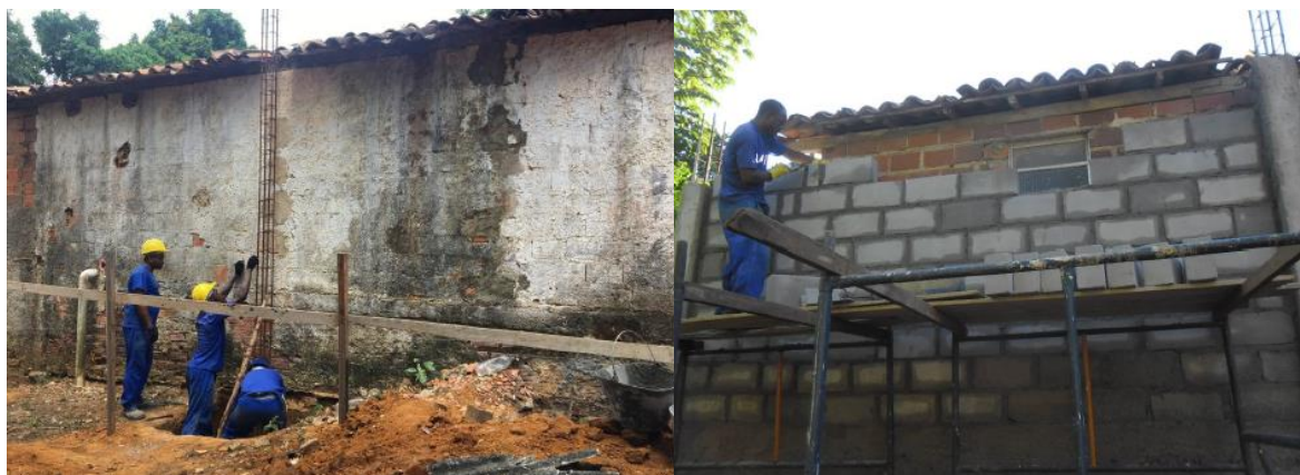
Figura 61 – Confeção das ferragens dos pilares novos do sagrado e Levante de parede do sagrado. Fonte: 3º RELATÓRIO FOTOGRÁFICO – PERÍODO DE 21/11/2018 A 31/12/2018 686 .
