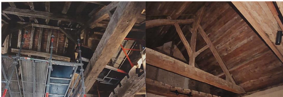
Figura 145 – Antes e depois da intervenção de 2021.
