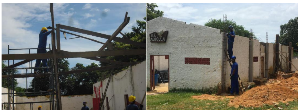
Figura 60 – Desmontagem do madeiramento antigo deteriorado do telhado do barracão e montagem dos pilares novos.
