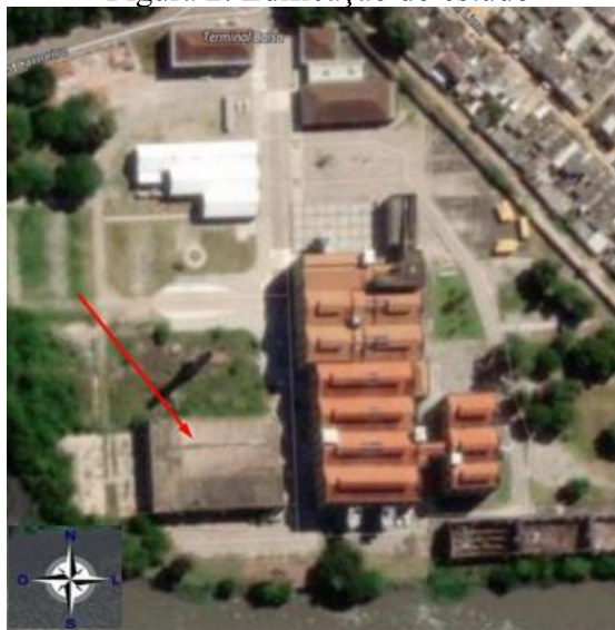
Figura 2: Edificação do estudo
