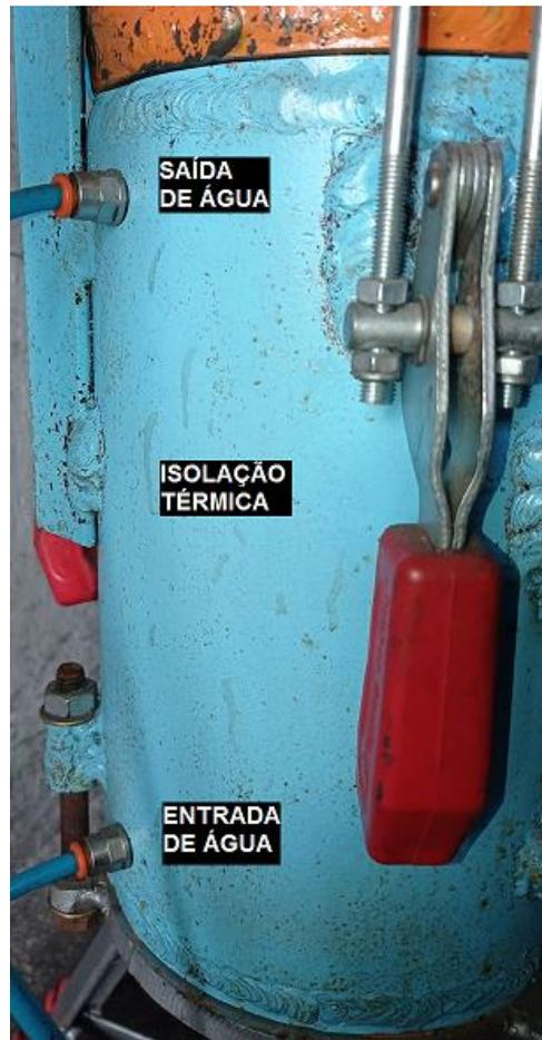
Figura 39 – Isolação térmica.
