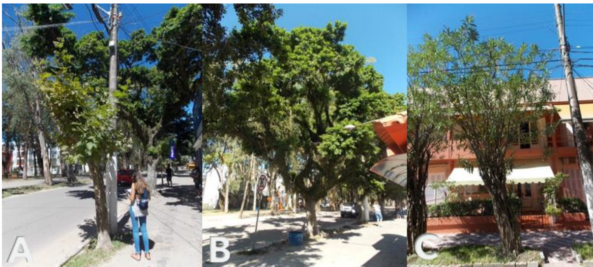
Figura 26- Observação de exemplos de conflitos da arborização com a rede elétrica. Fonte: Autor.
