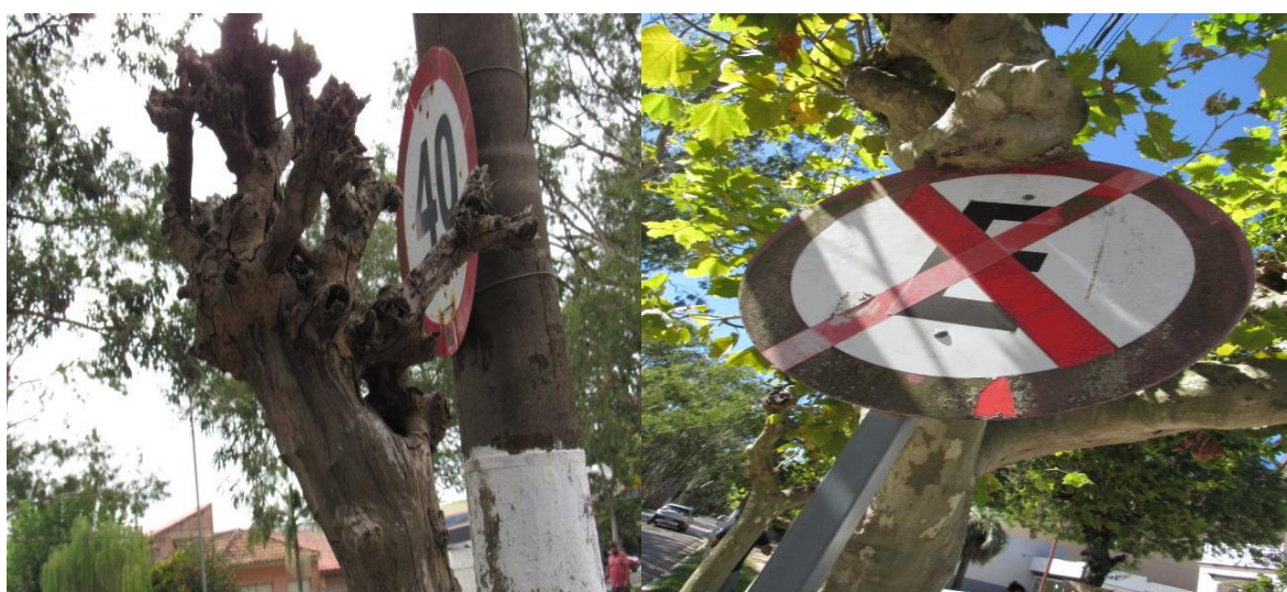
Figura 30: Observação de exemplos de conflitos da arborização com placas de sinalização. Fonte: Autor.
