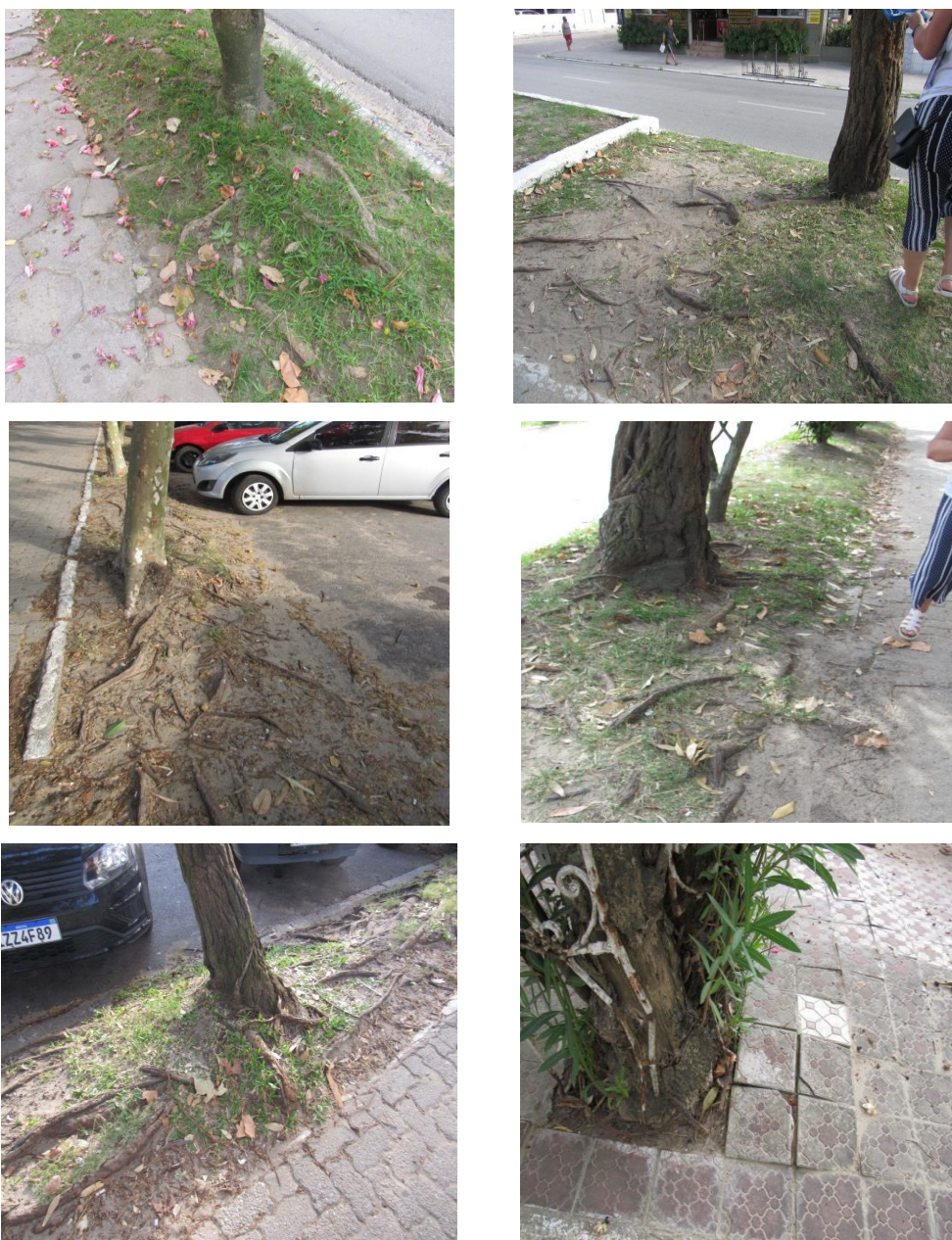
Figura 32: Observação de exemplos de conflitos da arborização com o passeio público.
