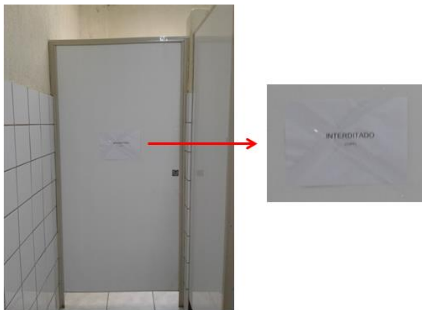
Figura 12: Interdição de banheiro por vazamento de água, em maio de 2019. Fonte: Autor.
