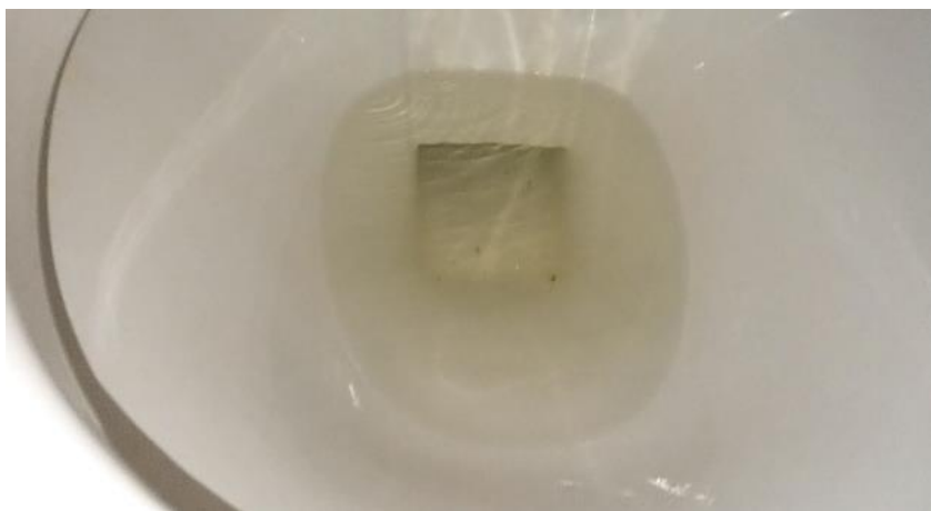
Figura 8: Vazamento de água do tipo filete em bacia sanitária. (Vídeo disponível em: youtube.com/watch?v=gCx6-nM4kkQ ) Fonte: Autor.
