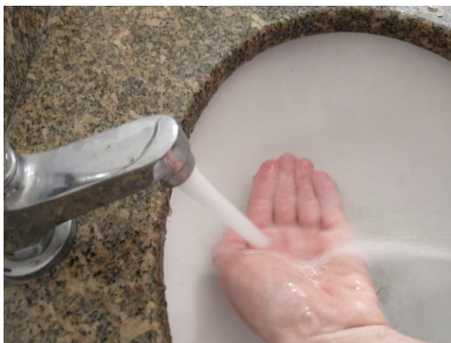
Figura 16: Vazão em excesso em lavatório do Campus Porto. Fonte: Autor.
