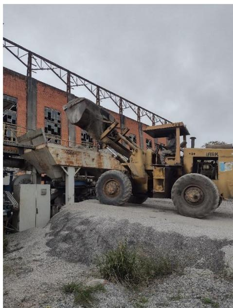
Figura 8 - Carregamento dos agregados no silo
