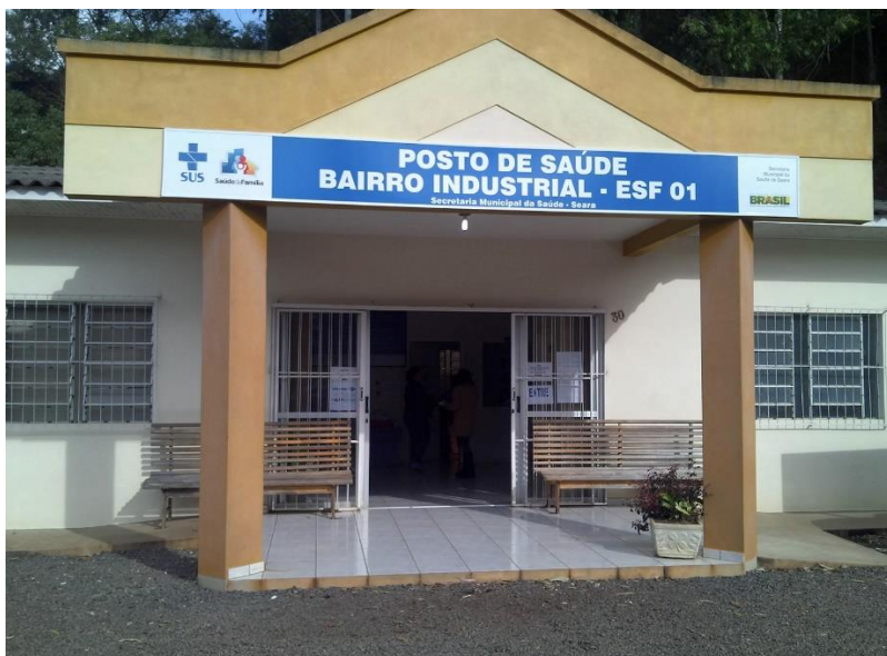
Figura 4. Fotografia da visão externa de uma unidade de saúde visitada pela Avaliação Externa do PMAQ-AB.
