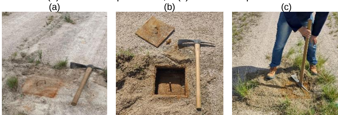
Figura 5 – Instrumentações encontradas com o auxílio de GPR: (a) piezômetro; (b) marco de superfície 01; e (c) marco de superfície 02.
