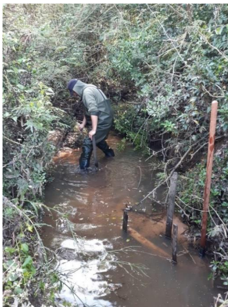
Figura 5 – Fixação de torpedos da área 3. Fonte: elaborada pelo autor (2024).
