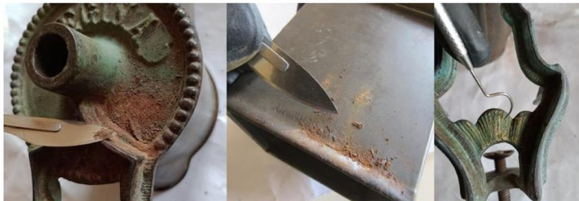
Figura 1: Retirada da oxidação, ferrugem e sujidades. Foto: Társis Gradaschi.
