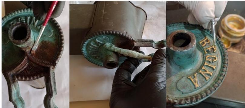
Figura 2: proteção do metal, limpeza química e reintegração cromática. Fonte: Társis Gradaschi
