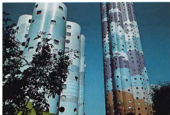
Figura 2.2 - Blocos de apartamentos, Nanterre. Arquiteto: E. Aillaud. Consultor de cores: F. Rieti. Fonte: PRIETO, 1995, p.7.
