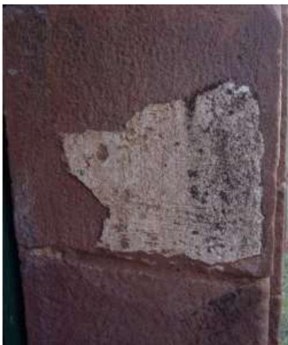
Figura 8. Fragmento de reboco utilizando tabatinga e cal feita de caracóis.
