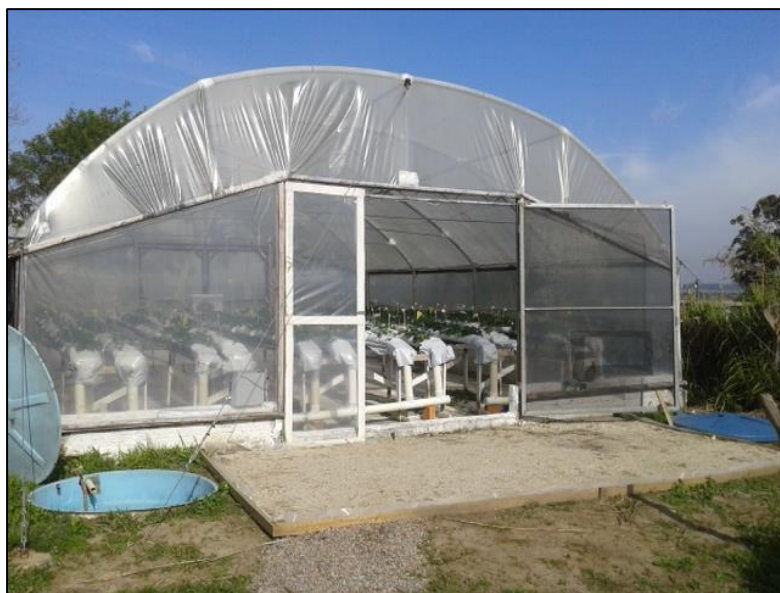
Figura 1 B. Estrutura de cultivo protegido, abrigo, onde os experimentos foram desenvolvidos. Pelotas, 2016. Fonte: Douglas Schulz.
