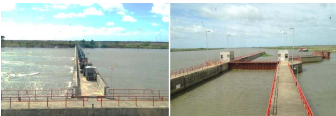
Figura 2 – Comportas da barragem e Canal da Eclusagem (Gouvêa, 2009)
