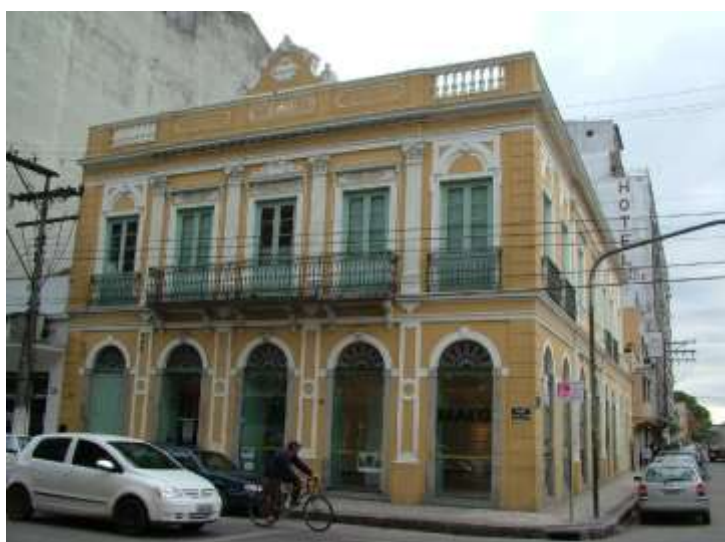
Figura 20: Prédio do Museu de Arte Leopoldo Gotuzzo, rua General Osório, 2003. Fonte: MALG, Acervo.
