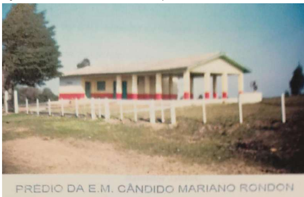
Figura 104 - Vista do Prédio da Escola Municipal Cândido Mariano Rondon
