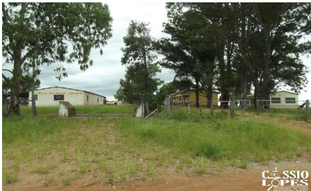
Figura 100 - Vista da entrada e estrutura da Escola Colônia Salvador Jardim
