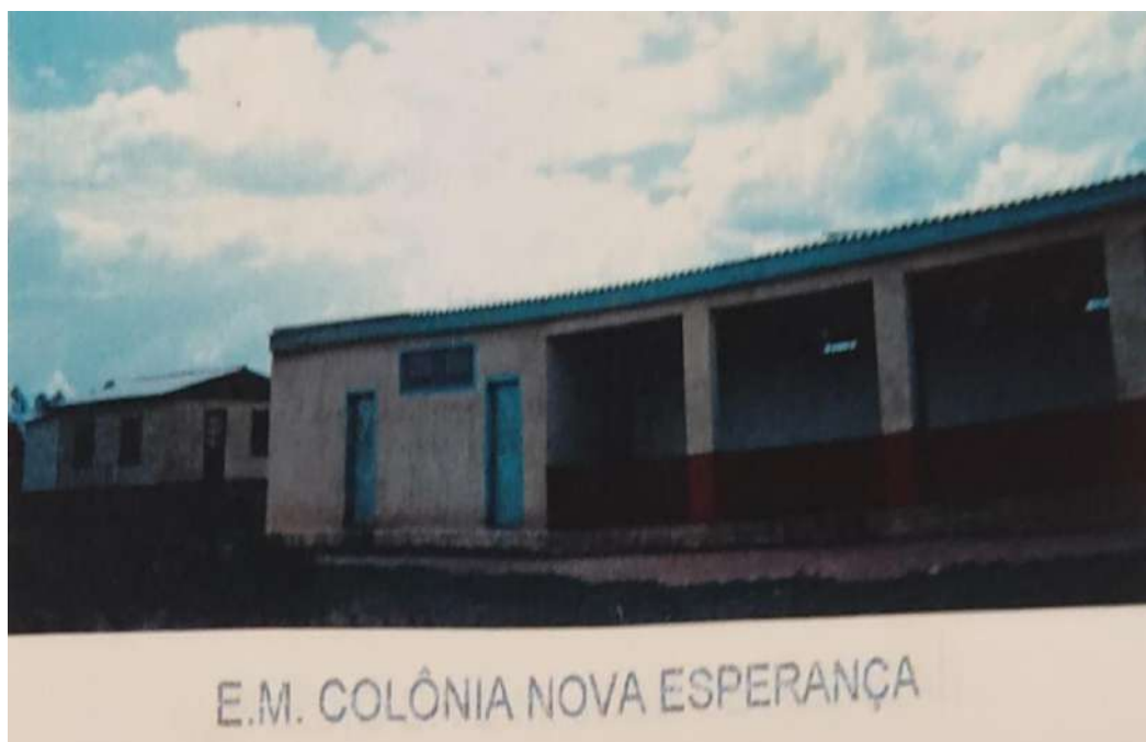
Figura 86 - Fachada da Escola Colônia Nova Esperança
