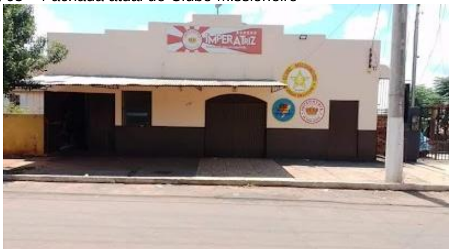
Figura 63 – Fachada atual do Clube Missioneiro
