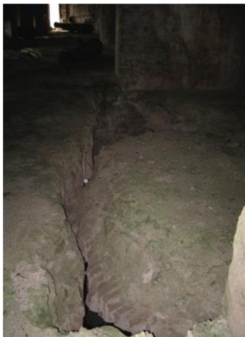
Figura 15 - Deslocamento das abóbadas, Cidadela.
