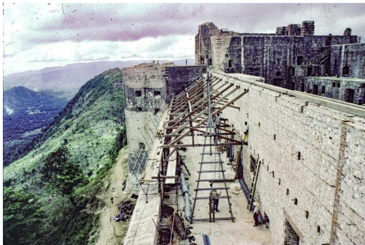
Figura 18 - Obras de Restauração da Cidadela em 2012
