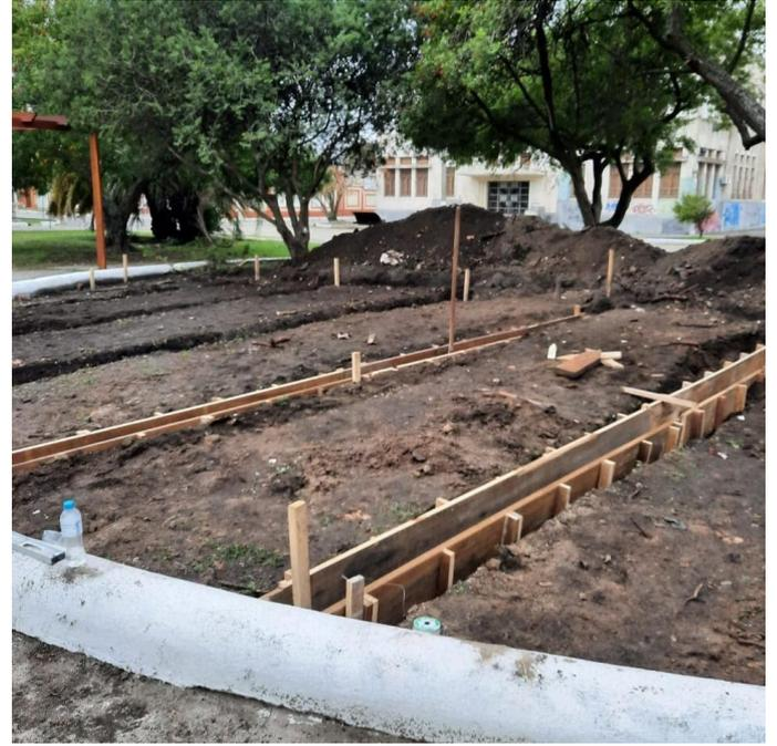
Figura 2 - Terreno regularizado/nivelado e fôrmas instaladas
