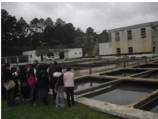
Figura 2: Visita a estação de tratamento de água Santa Bárbara – SANEP
