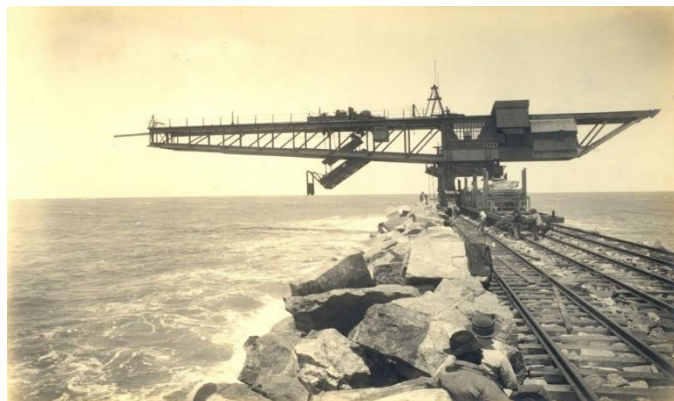
FIGURA 2 – Final da estrada de ferro do Porto do Rio Grande. Construção dos Molhes da Barra. Molhe Oeste
