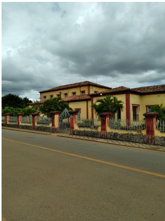
Figura 56: Fachada bloco administrativo.
