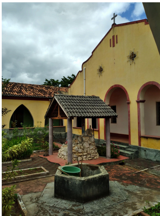
Figura 53: CCAD, pátio do bloco administrativo.
