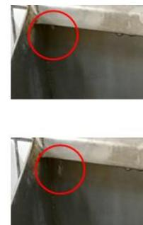
A perda de água apresentada na Figura 1 foi verificada no banheiro masculino localizado no pavimento térreo no bloco B. O vazamento se caracteriza como um filete de água contínuo, com diâmetro de até 2 mm, proporcionado por falha de estanqueidade no obturador ou na válvula de boia. Nestas condições GONÇALVES *et al.* (2005) estimam a perda diária a partir de 144 litros, o que representa aproximadamente 52 m<sup>3</sup> de água ao ano.
