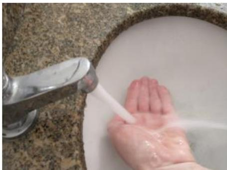
Figura 4: Vazão em excesso em lavatório do Campus Porto.
