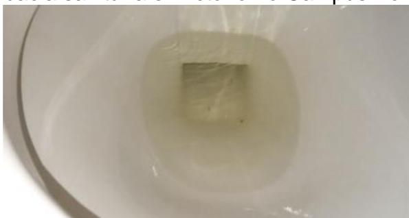
Figura 1: Vazamento em bacia sanitária. Fonte: Autores.
