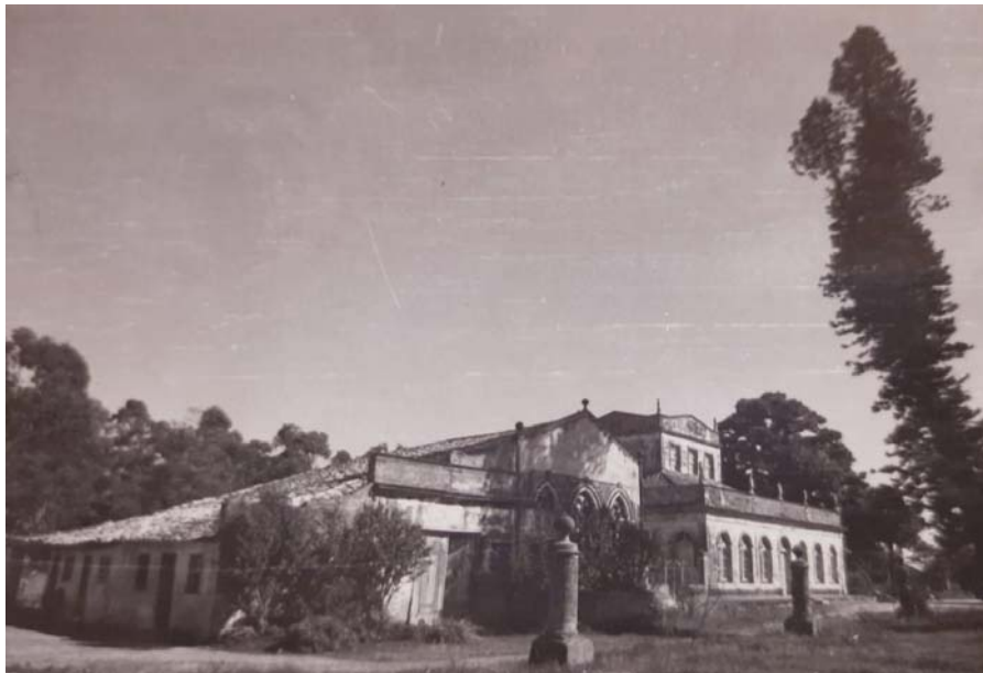
Figura 5: Casaão nos anos 1970, em que é visível a estrutura da garagem e as dependências de “empregados ou escravos”. Fonte: Acervo MMPB.
