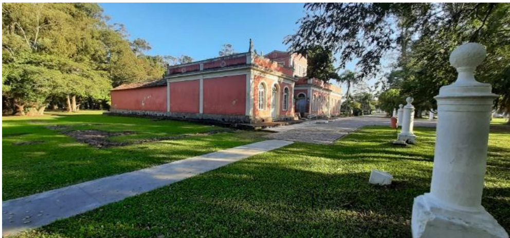
Figura 6: Casaão atual do Museu da Baronesa, Mostra a fachada, sem as estruturas que foram suprimidas no processo de restauração. Fonte: Marcelo Madail.
