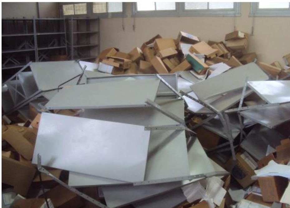
Figura 1 - Acidente na sala de processamento do Arquivo Geral no Campus Cidade da Universidade Federal do Rio Grande – FURG em 2010
