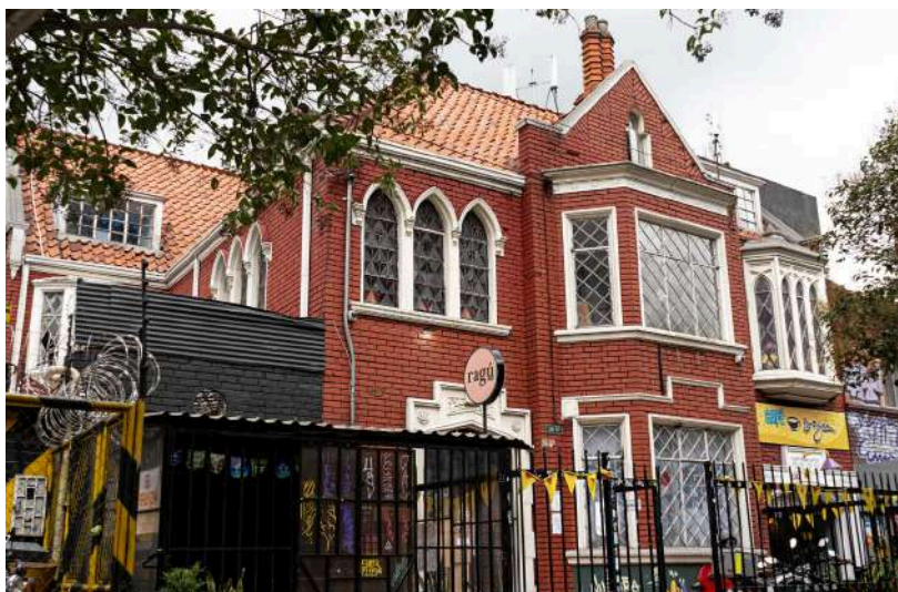
Foto 11. Fachada de ‘La Casa de la Paz’
