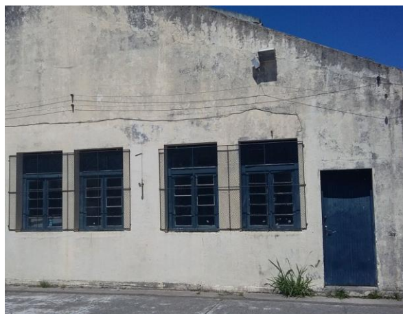
Figura 1: Prédio destinado para o arquivo morto
