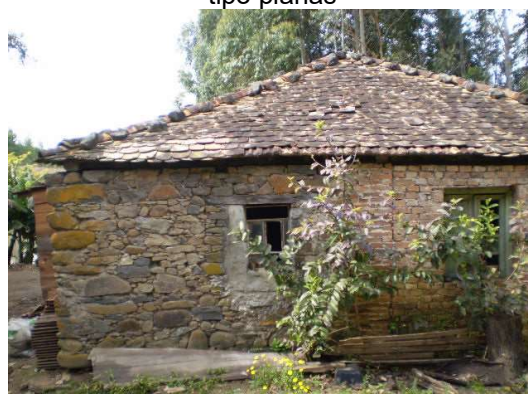
Figura 103 – Telhas cerâmicas antigas, do tipo planas
