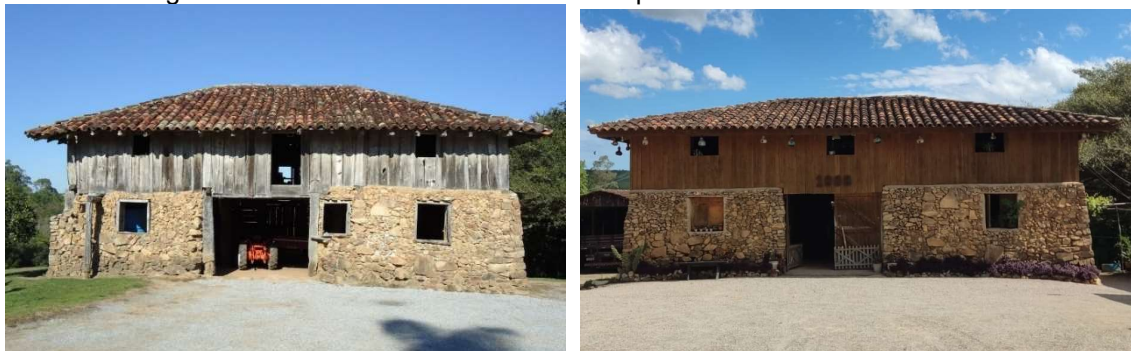
Figura 51 - Altura da cumeeira antes e depois da reforma – vista externa
