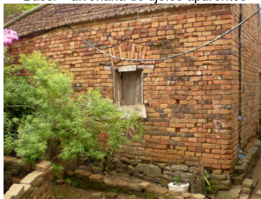
Figura 4 - Fundos da casa do imigrante José Bassi – alvenaria de tijolos aparentes
