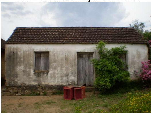
Figura 3 – Frente da casa do imigrante José Bassi – alvenaria de tijolos rebocada
