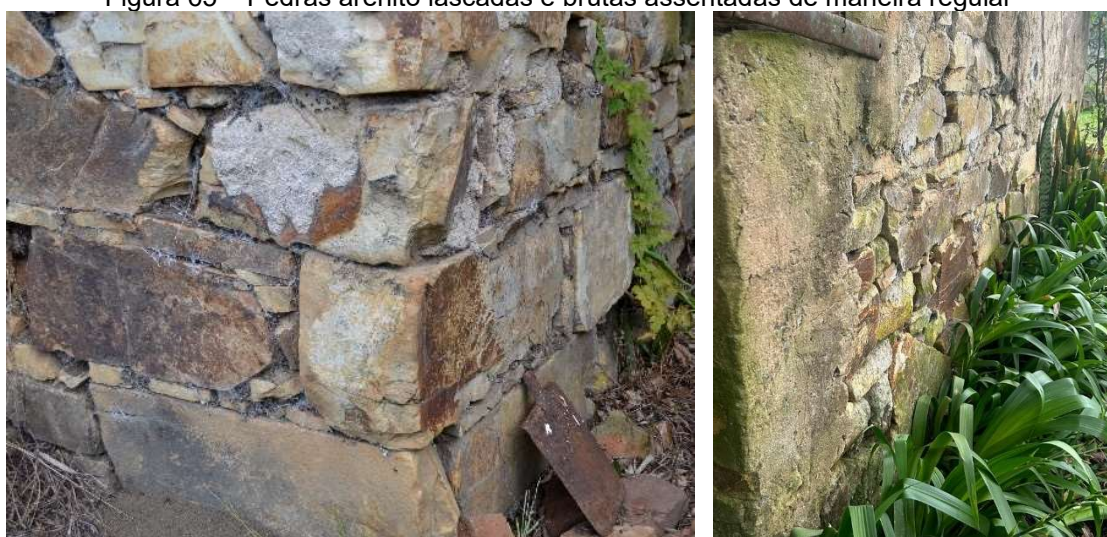
Figura 65 – Pedras arenito lascadas e brutas assentadas de maneira regular
