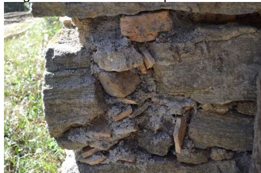
Figura 101 – Detalhe dos preenchimentos
