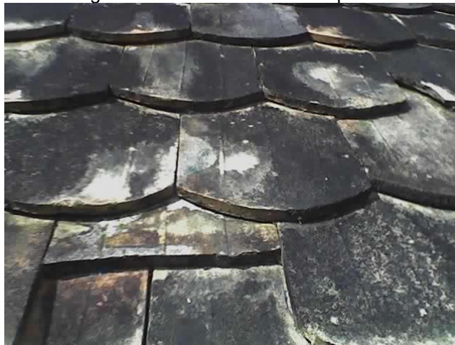
Figura 105 - Telhas cerâmicas planas
