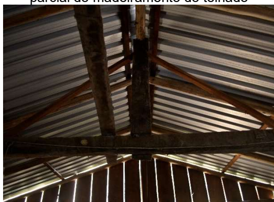
Figura 102 – Telhas metálicas e renovação parcial do madeiramento do telhado
