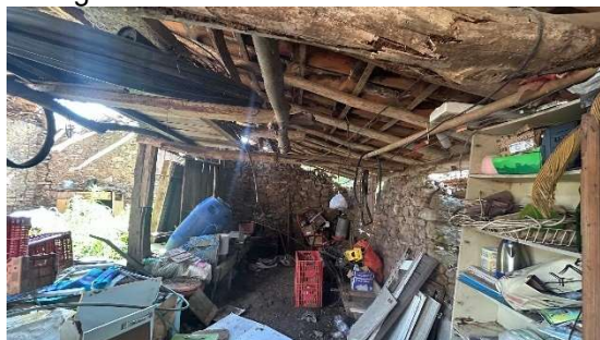
Figura 114 – Madeiramento do telhado
