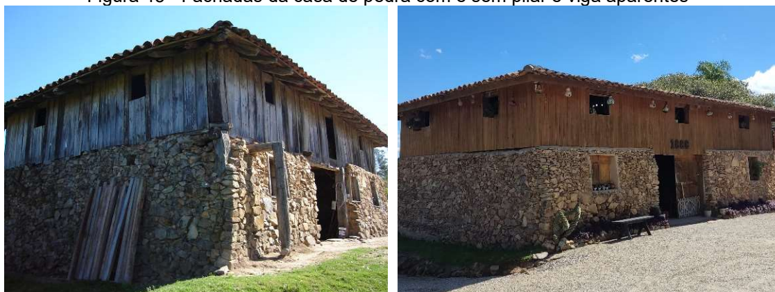
Figura 45 - Fachadas da casa de pedra com e sem pilar e viga aparentes
