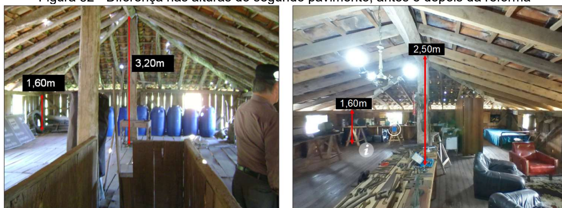
Figura 52 - Diferença nas alturas do segundo pavimento, antes e depois da reforma
