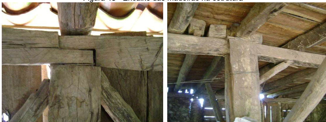
Figura 48 - Encaixe das madeiras na estrutura
