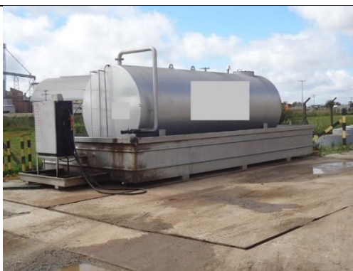
Figura 4 – Bacia de contenção
