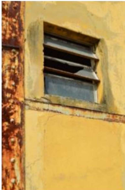
Figura 14 - Corrosão das estruturas e aberturas metálicas pela ausência de manutenção
