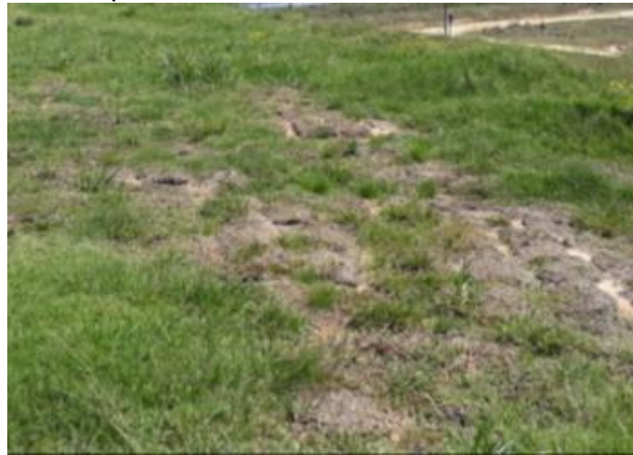
Figura 12: Início dos processos erosivos instalados na face Se do Aterro Sanitário de RSU
