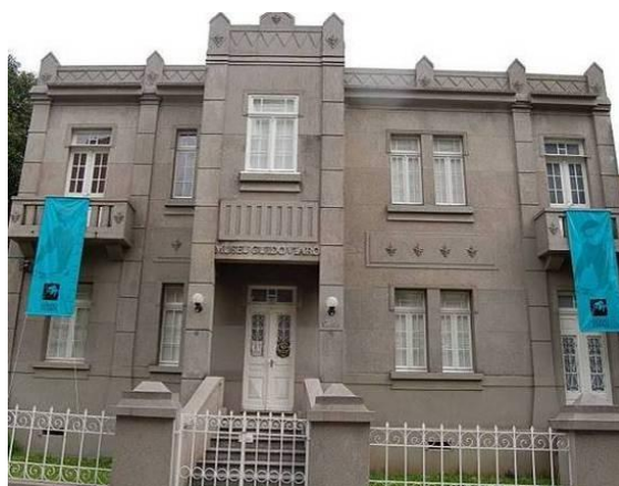
Fachada do Museu Guido Viaro. Fonte: www.museuguidoviaro.org
