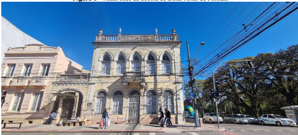
Figura 1 – Atual sede da Escola de Belas Artes de Pelotas.
