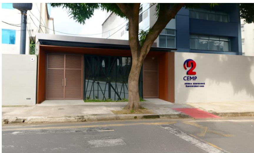
Figura 36 - Fachada principal do CEMP.
