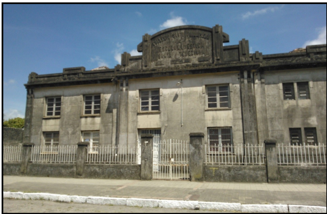
Figura 19 –Fotografia da fachada das antigas instalações do Collegio Santa Philomena e Escola Domestica Santa Terezinha, em janeiro de 2015.
