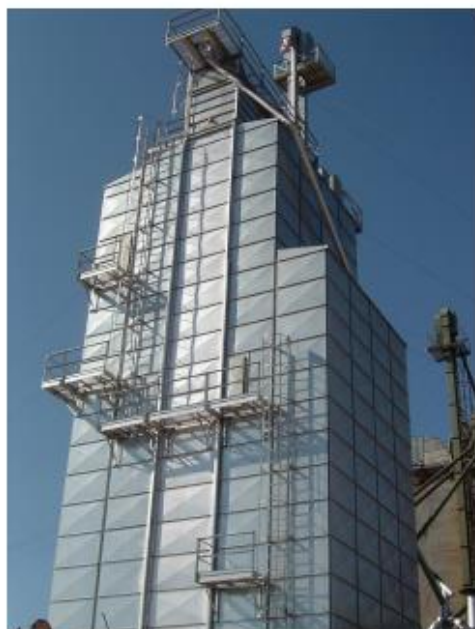
Figura 10 – Fluxo ar misto (A). Fonte: Kepler, 2009.
