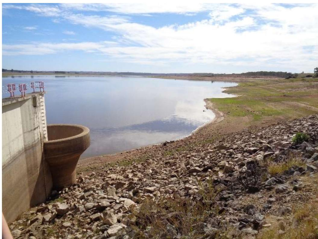
Figura 39 – Vista da Tulipa da Barragem do Chasqueiro (Lat:  $-32.163535^\circ$ , long:  $-53.010700^\circ$ ) - em maio. 2015, em período seco.
